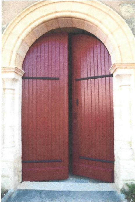
Le porche d'entrée entièrement refait.
