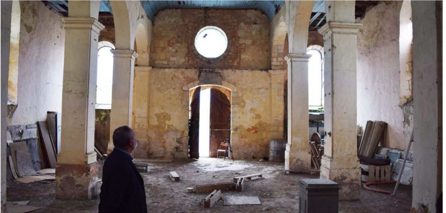
L'église avant le démarrage des travaux, en 2016
