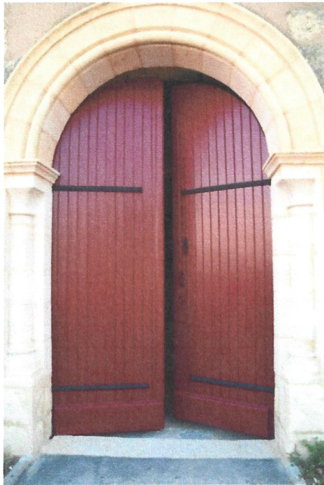
Le porche d'entrée entièrement refait.
